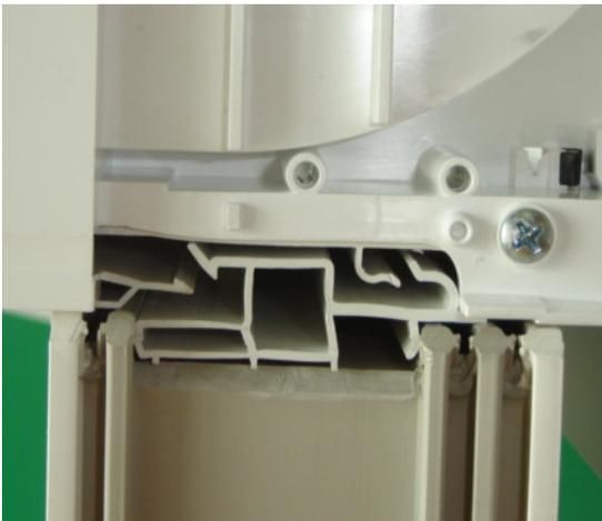
Aufsatzkasten von innen auf das Adapterprofil aufsetzen
